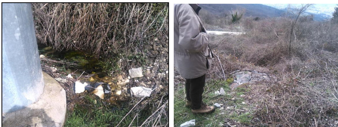
Foto 3 e 4 – Ristagno di acque non canalizzate al di sopra della strada, marzo 2013
